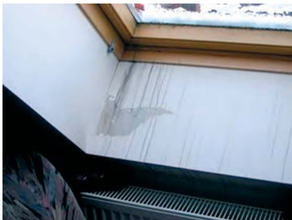
K obrázkům: Častou příčinou poruch odvětrání střech bývá nepropojení sousedních větracích mezer tam, kde je odvětrávací mezera přerušena prostupujícím prvkem.
